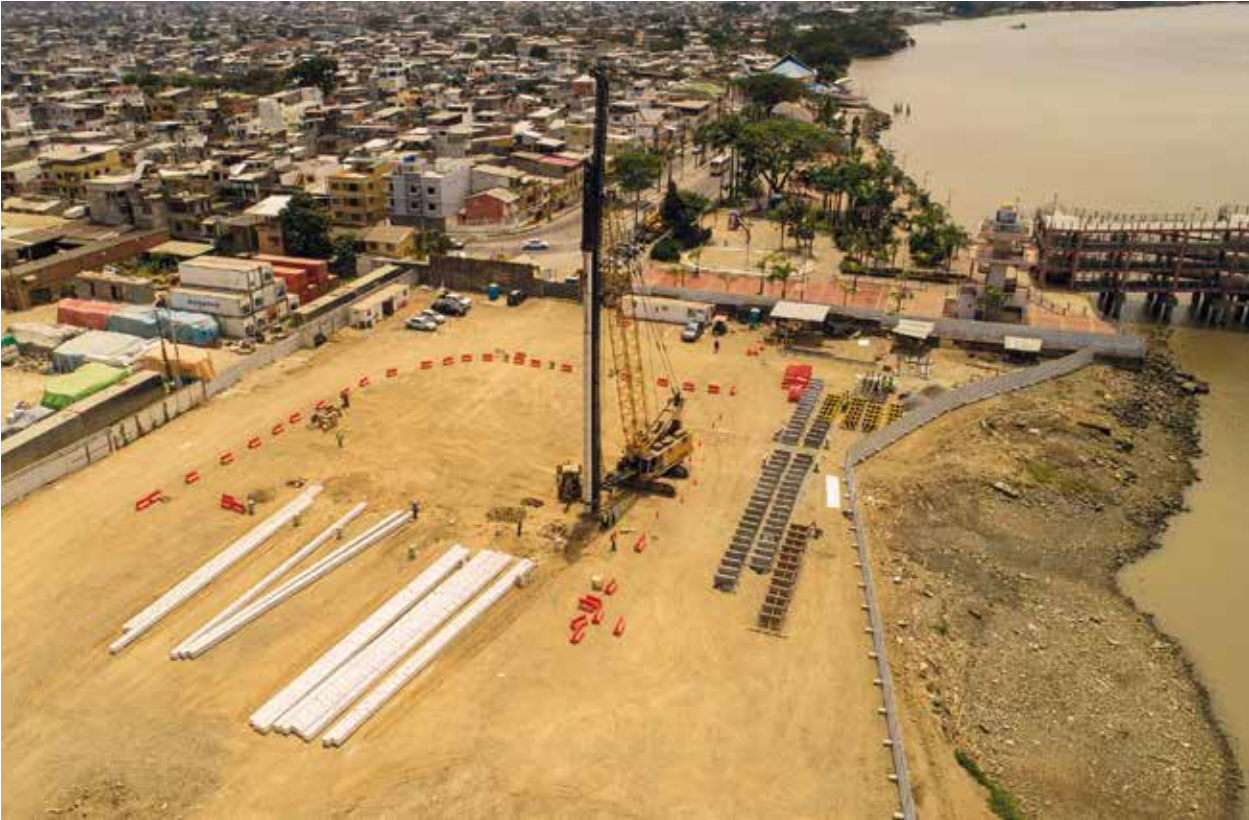
Aerovía, Guayaquil, Ecuador Precast Piles
