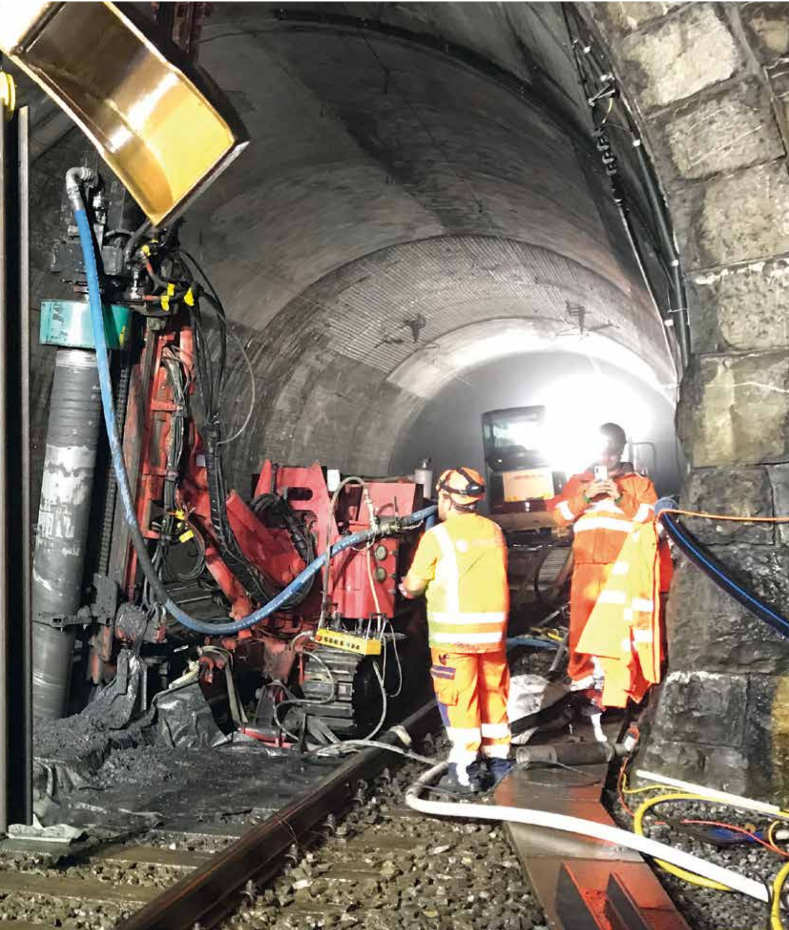
Bommersteintunnel Sbb Quarten Ch Rhomberg Mikropfähle, Quarten (Switzerland) GRO
